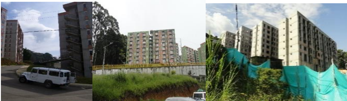
Ilustración 6]De izq a der: Acceso a los edificios por el piso 3. Barreras físicas. Urbanización suspendida. El autor, mayo de 2009(foto izq.) y abril de 2015 (centro y der.)
